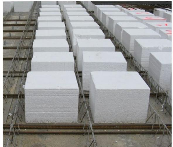
Inoltre, optando per la scelta di elementi di alleggerimento in materiale plastico o EPS vergine (in luogo dei consueti blocchi in polistirene espanso rigenerato normalmente utilizzati) è possibile prevenire il potenziale accumulo di acqua per quei manufatti che, durante lo svolgersi delle fasi costruttive dell'edificio, si siano ritrovati esposti agli agenti atmosferici.
