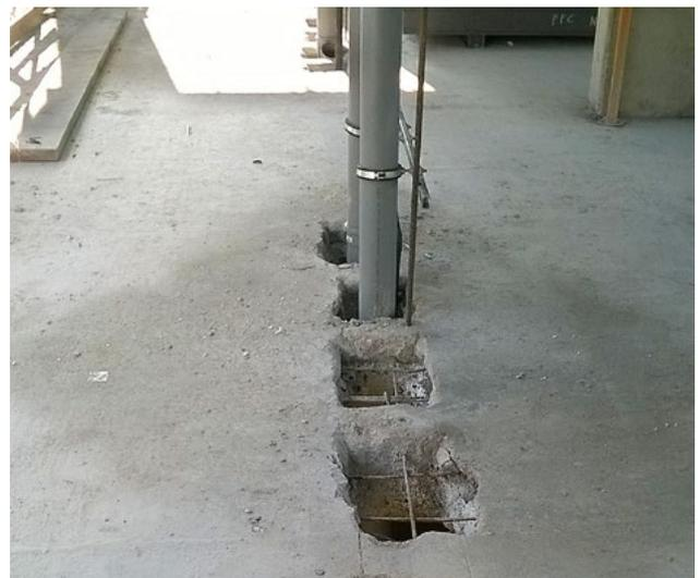
In particolare le forometrie possono essere alternativamente predisposte nelle lastre in fase di produzione o ricavate mediante demolizione delle lastre in situ, senza necessità di creare cordoli ad hoc ed eventualmente anche in corrispondenza di posizioni normalmente non praticabili nel caso di impalcati tradizionali per via della presenza delle travi.
