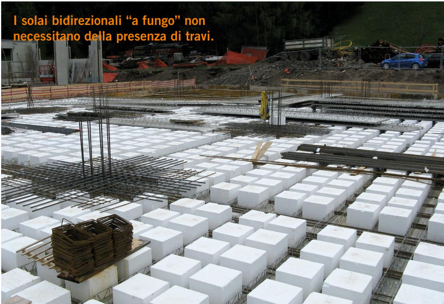
**I solai bidirezionali "a fungo" non necessitano della presenza di travi.**
