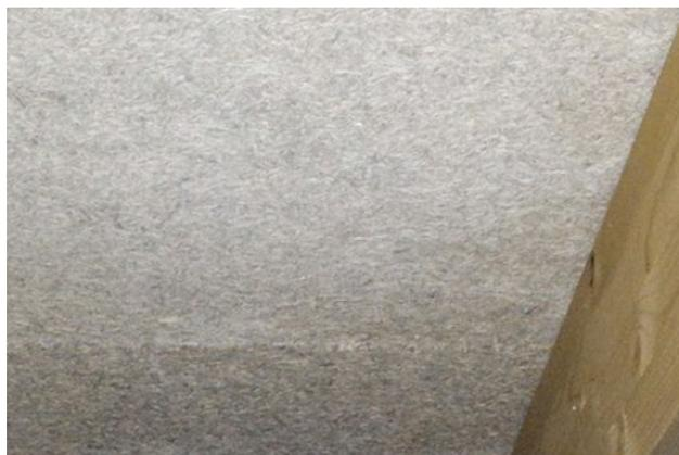
Il trattamento **Focus®** prevede l'applicazione all'intradosso delle lastre di uno strato in argilla espansa di spessore 2÷3 cm in grado di conferire al manufatto numerosi vantaggi e proprietà:
