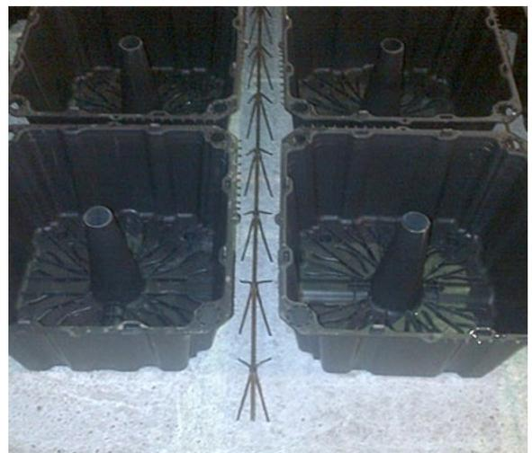
L'armatura resistente a taglio e a punzonamento viene realizzata mediante posa di ferri piegati e trallicci i quali possono anche rivestire la funzione di distanziale nei confronti dell'armatura superiore e della rete elettrosaldata. In alternativa è possibile ricorrere a chiodature e trallicci speciali.
