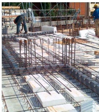
Il solaio **DUAL Solution**® può anche essere integrato in modo armonico e in assenza di interferenze con connettori strutturali termoisolanti **Esse Therm**®. Il corretto inserimento dei connettori **Esse Therm**® tra file di lastre in corrispondenza degli aggetti permette di conseguire la continuità dell'isolamento verticale.
