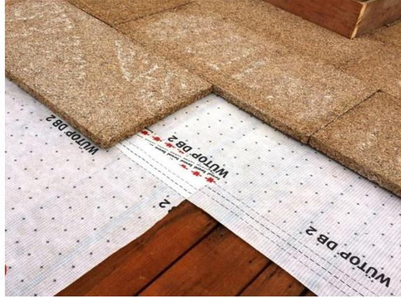
Rimozione della lamiera grecata e posa del freno a vapore e dei pannelli in legno mineralizzato
