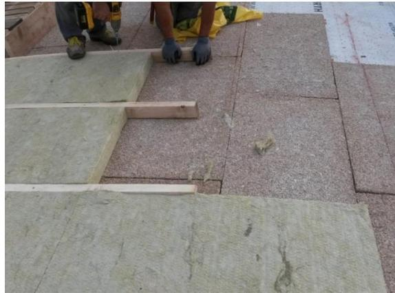
Completamento della posa dei pannelli in legno mineralizzato e posa dell'isolante
