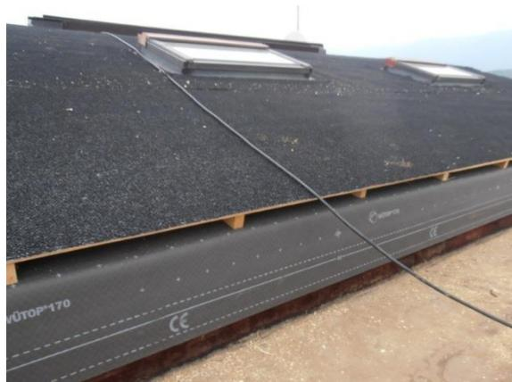
Installazione del telo traspirante impermeabile e dettaglio del risvolto in corrisp. della presa di ventilazione
